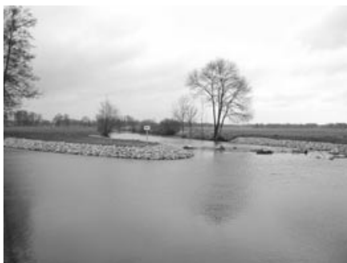
Die Einfahrt in den wiederangeschlossenen Altarm unterhalb des unteren Puhlstromwehres. Rechts im Bild: Die Überlaufschwelle im Puhlstrom zwingt den größten Teil des Wassers jetzt durch den Altarm. Dieser kann von Kähnen und Paddelbooten befahren werden.
