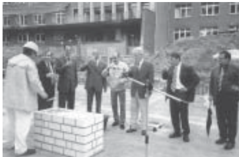
Baubeginn für ein neues Bettenhaus in Königs Wusterhausen (Foto: LDS)
